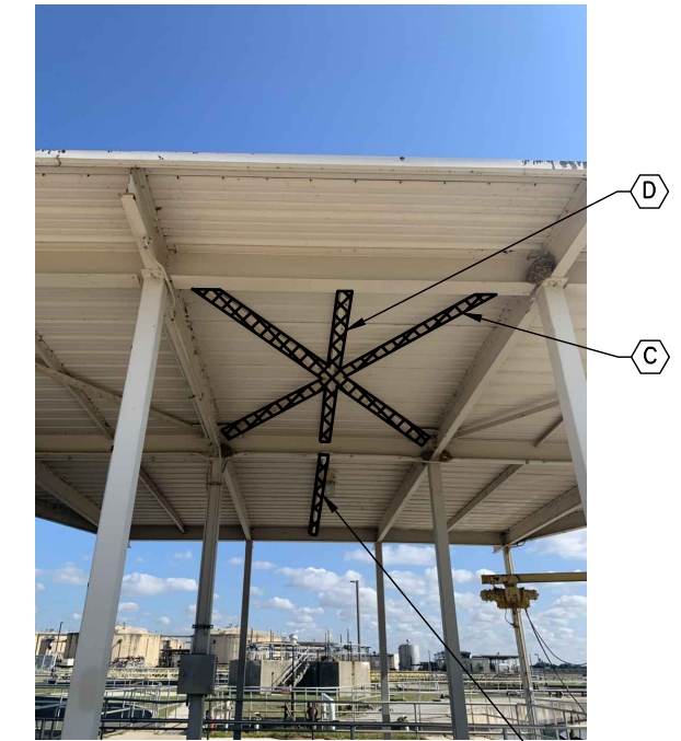
3 D2 ROOF FRAMING DEMOLITION (TYPICAL) SCALE: N.T.S.
